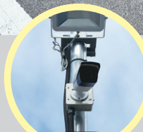
防犯カメラ設置
